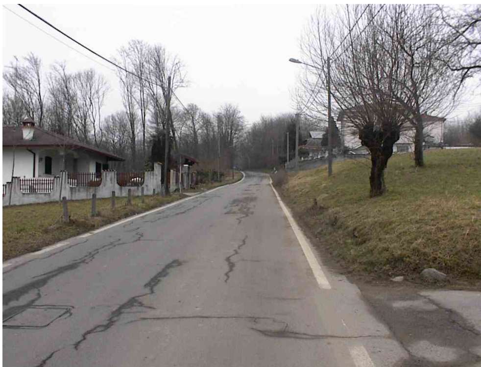
Foto n. 9 – Via delle Industrie
