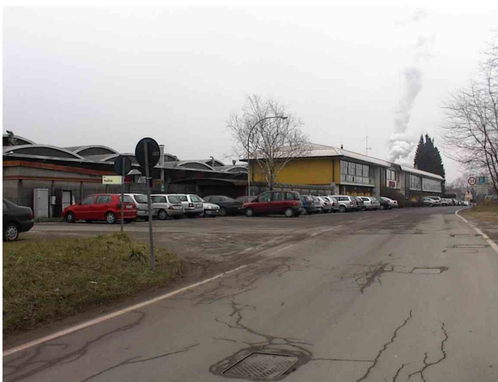
Foto n. 10 – Via delle Industrie
